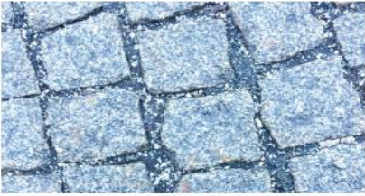
Nachteil Streusalz: Keine Wirkung am Kopfsteinpflaster, da das Salz in die Zwischenräume fällt.
