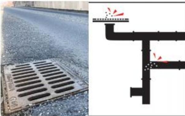
Nachteil Splitt: Verstopfen der Entwässerungsanlagen, Einlaufschächte und Rohrleitungen (Kanalisation).
